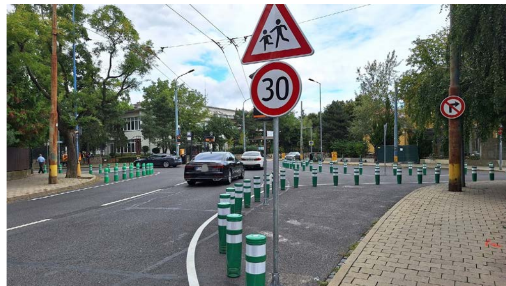
obr. 22.: Príklad dočasnej zmeny geometrie križovatky na Mudroňovej ulici v Bratislave. Zúženie neprehľadne širokej cesty a zmenšenie rádiusov pre celkové upokojenie a sprehľadnenie situácie pri škole. Realizovali sa najskôr vo forme rýchlych a lacných riešení pomocou prefabrikovaných stĺpikov, kým sa nová situácia otestuje a nájdu sa financie na stavebné riešenie. Foto: Bratislavské noviny
