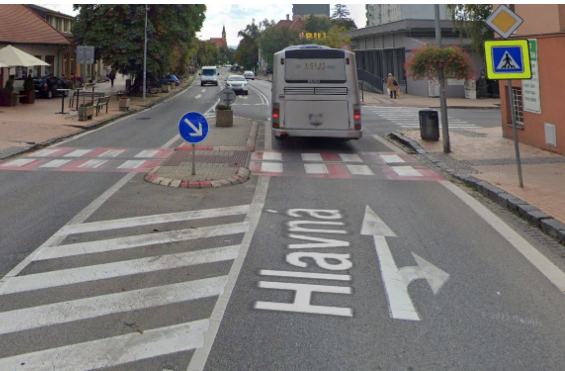
obr. 21.: Stredový ostrovček pre chodcov v Stupave na hlavnom prietahu obcou. Chodci nemusia prechádzať cez celú šírku cesty naraz a autá automaticky spomalia. Foto: Google maps
