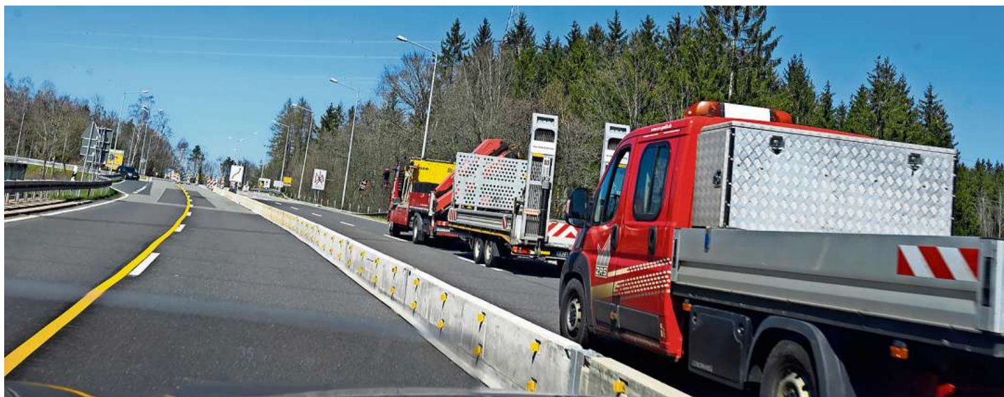
Der Brückenbau am Friedberg beginnt, die Hälfte der Straße ist für Technik und Baufahrzeuge gesperrt.
