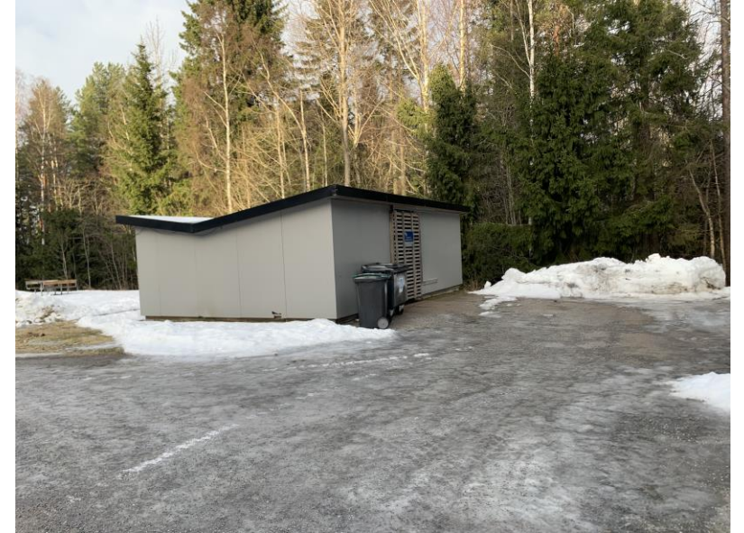
Arbeidslivsbygget [workexperience for students]
