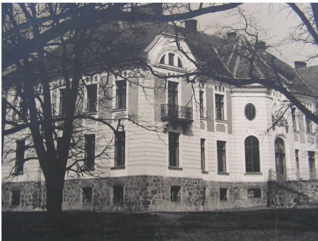
Pałac w Weryni – rezydencja Tyszkiewiczów, wykorzystywany jako budynek szkolny i internat (zdjęcie wykonane w latach 1963/64 r. prawdopodobnie przez Franciszka Batorego – przyp. autora).
